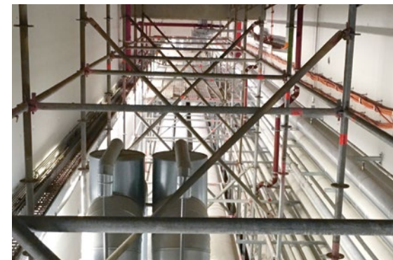
Das Dauerproblem am BER: Die nicht funktionierende Entrauchungsanlage.
