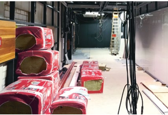
Tausende Kilometer Kabel, offene Decken und eine Technik, mit der sich niemand auskennt.
