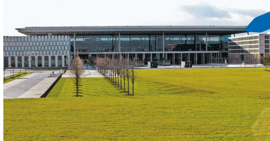
Nichts los am BER: Die Restarbeiten dauern auffällig lange für ein verhältnismäßig einfaches Terminalgebäude.
