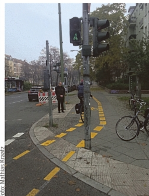
Malmöer Str. Ecke Bornholmer Straße
